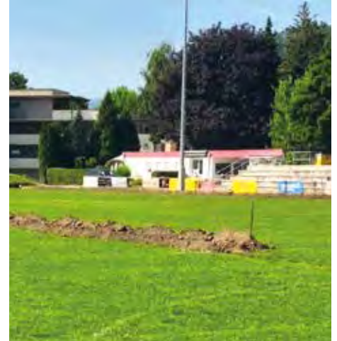
Vollautomatische Bewässerung entsteht
