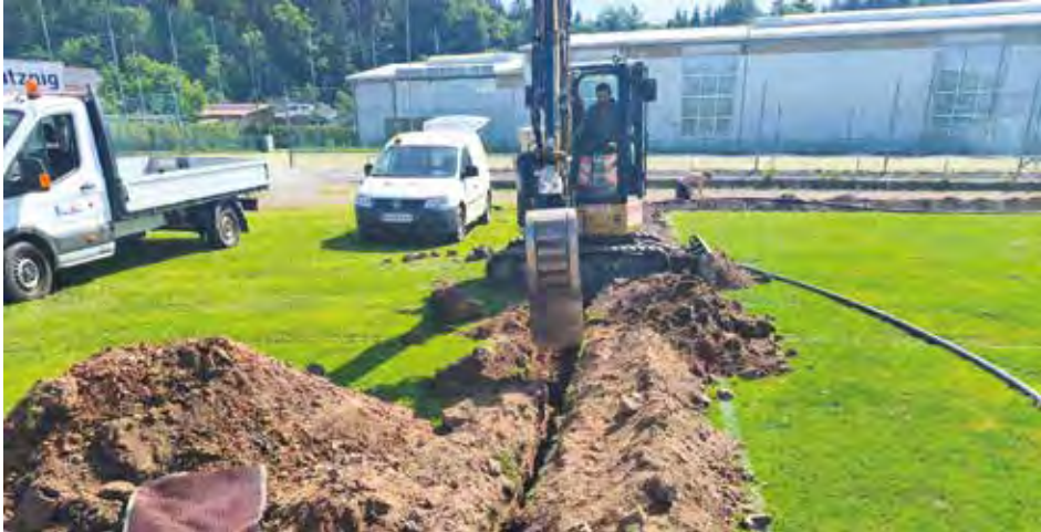
Grabungsarbeiten laufen auf Hochtouren
